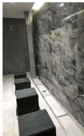
BLOC SANITAIRE A DU SEA PLAZA: CARRELAGE INTÉRIEURS SOLS , MURS ET PLANS VASQUE; AINSI QUE LA RÉALISATION DES MAÇONNERIES
