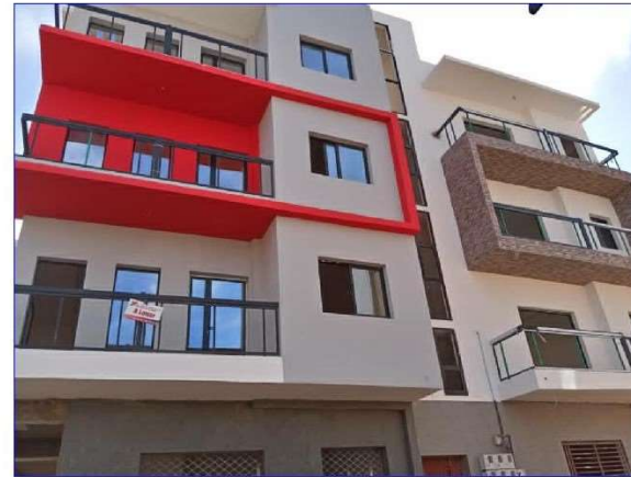
REALISATION DU GROS OEUVRE ET DE TOUS LES CORPS D'ETATS SECONDAIRES
