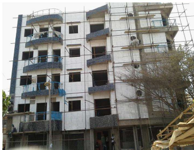
IMMEUBLE À SCAT URBAM: POSE CARRELAGE AU NIVEAU DE LA FAÇADE
