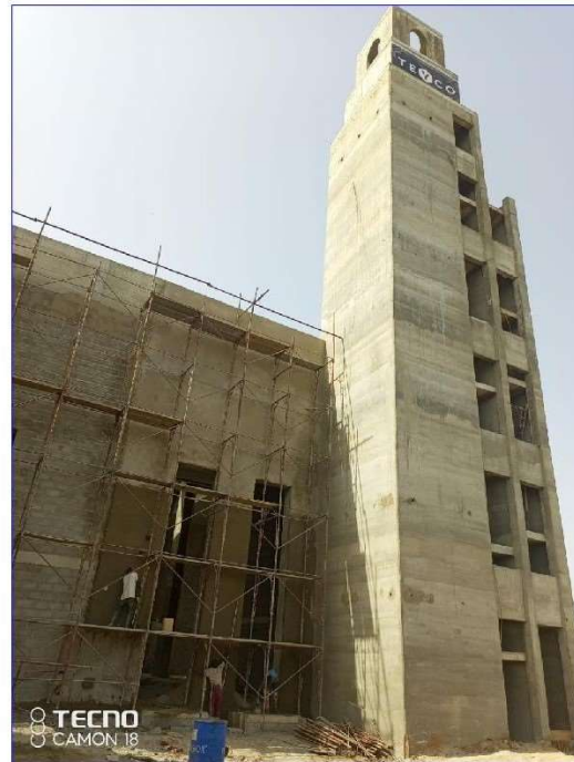
REALISATION DE L'ENDUIT EXTERIEUR
