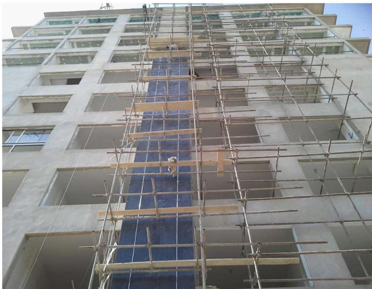
IMMEUBLE À DAKAR AU CENTRE VILLE: CARRELAGE INTÉRIEURS ET EXTÉRIEURS RÉALISÉ; SUR LA PHOTO CARRELAGE DE LA FAÇADE
