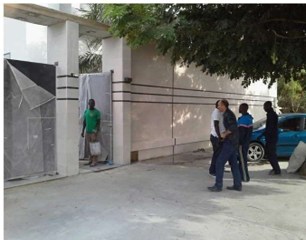
VILLA À FANN RÉSIDENCE: CARRELAGE INTÉRIEURS ET EXTÉRIEURS RÉALISÉ; SUR LES PHOTOS CARRELAGE AU NIVEAU DU MUR DE CLÔTURE
