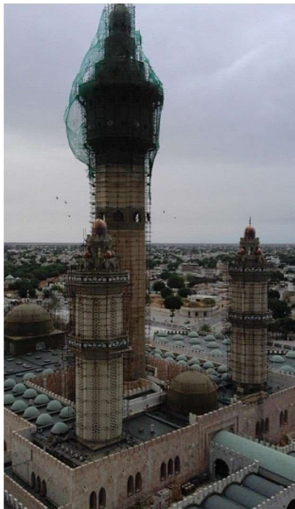
GRANDE MOSQUÉE DE TOUBA: CARRELAGE PAR FIXATION MÉCANIQUE DE MARBRE AU NIVEAU DES MINARETS ET POTEAUX INTÉRIEURS ET POSE DE PATE DE VERRE
